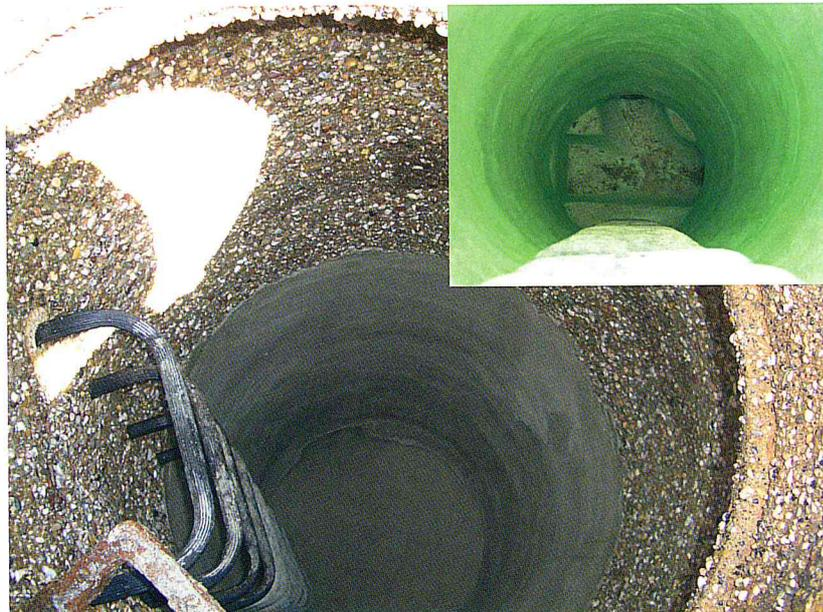
Schachtsanierung mit der Oberflächenversiegelung „Finish 288“.
