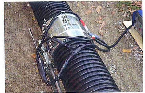
Schweißen von Flexoren-Rohren.
