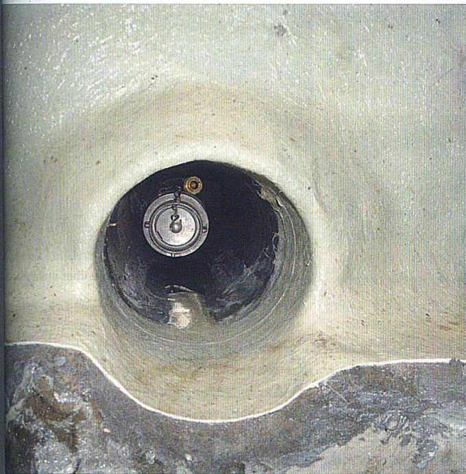
Anbindung des sanierten Altkanals an den Hauptsammler.
