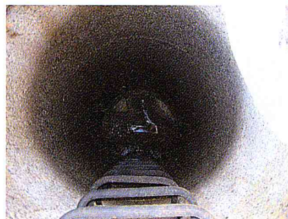
Abwasserschacht vor der Sanierung
